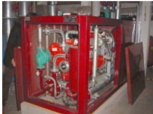
Stellt sich dabei nicht die von der Regelung vorgegebene Vorlauftemperatur für die Schulbeheizung ein, werden mit zeitlichem Versatz erst der ebenfalls neu installierte, fünf Kubikmeter große Pufferspeicher und dann die einzelnen Kesselzellen zur Wärmeabgabe freigegeben.
