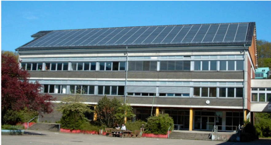
Abb.1: Das Aggertal-Gymnasium in Engelskirchen mit der 350 Quadratmeter großen PV-Anlage auf der Südseite des Schuldaches
